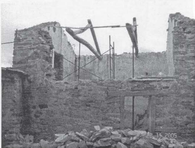
Restauración de edificación en Santiago Millas. Mantenimiento de la mampostería y de la estructura de madera de chopo de la cubierta
