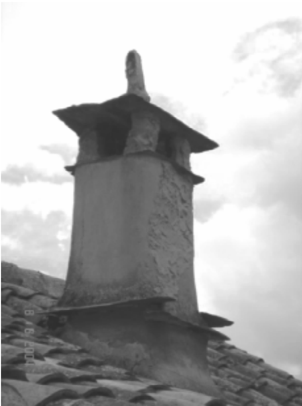
Chimenea casa Mallo. Castrillo de los Polvazares
