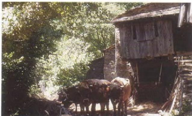
12- FORNA. Vivienda típica. La casa en su planta alta, destinada a vivienda propiamente dicha, gana amplitud con el corredor. Al ser las plantas de reducidas dimensiones, se amplían con los corredores de madera, que sirven como acceso a la vivienda buscando el soleamiento o como ampliación de la misma, dando lugar a los corredores abiertos o cerrados respectivamente.
