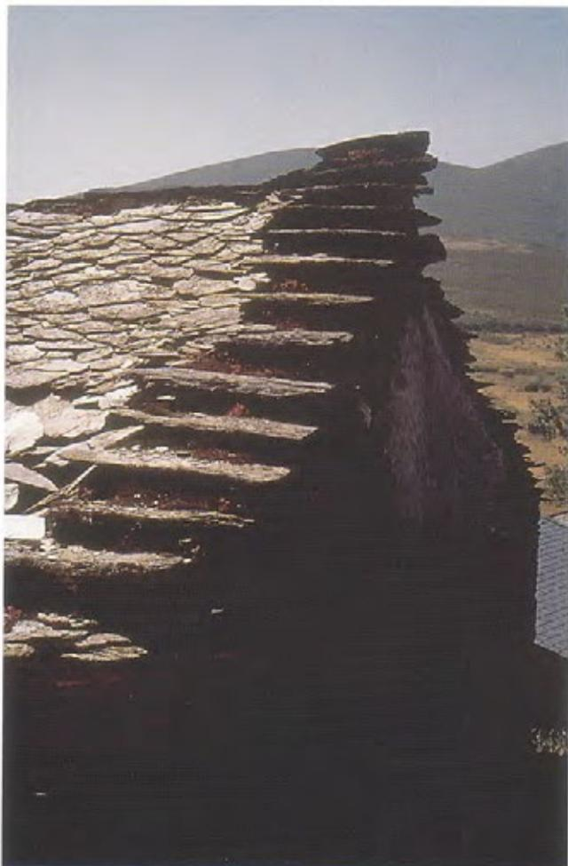
14- IRUELA. El material por excelencia en la Cabrera es la pizarra. Las edificaciones se cubre con losas toscas de esta piedra. En este caso vemos una cubierta característica de Pizarra rematada en testero de losas escalonadas. Es muy singular el reflejo del sol sobre la pizarra tosca.
