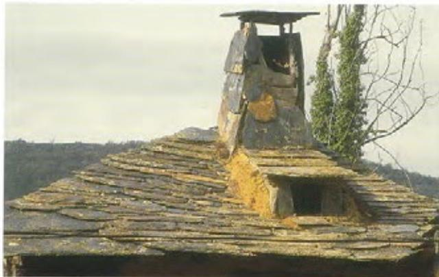
25- En esta chimenea de VILLAR DEL MONTE se observa además un hueco inferior de salida de humo (*burfarra* o *garroteira*).
