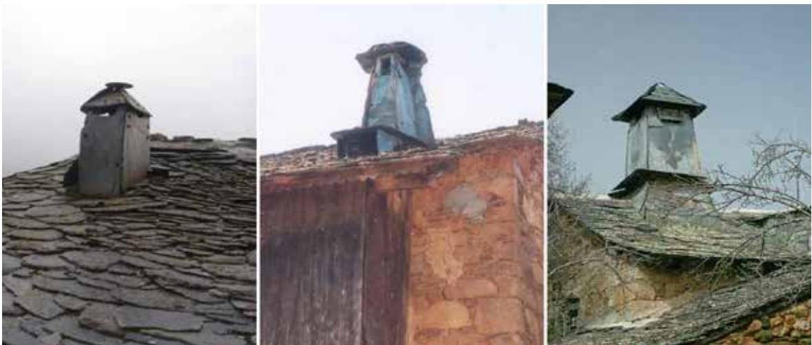
Losadilla. Villar del monte. Truchas. Fotografías: Concha Casado y Javier Sastre.
