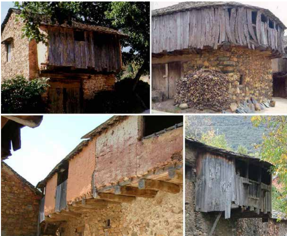
Corredor en Villar del Monte (Cabrera Alta). Manzaneda (Cabrera Alta). Corredor de entretejido vegetal enfoscado con barro, restos de encalado (Villar). Corredor semicerrado Ambasaguas (C. Baja). Fotografías: Concha Casado y Javier Sastre.
